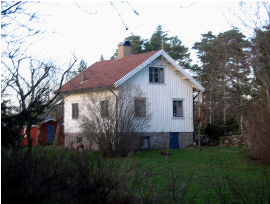
Ett äldre befintligt bostadshus inom planområdet med karaktär av gammal stenhuggarbostad
